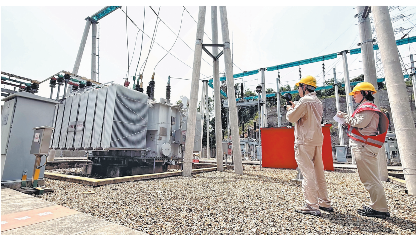
8月12日,为应对今年第11号台风“杨柳”,国网福安市供电公司迅速启动防台应急响应,组织运维人员对辖区110千伏山下变电站展开全面巡检。此次巡检以户外设备防水防潮为核心,同步强化站内排水系统及防涝设施的隐患排查,全力保障电网安全稳定运行。
