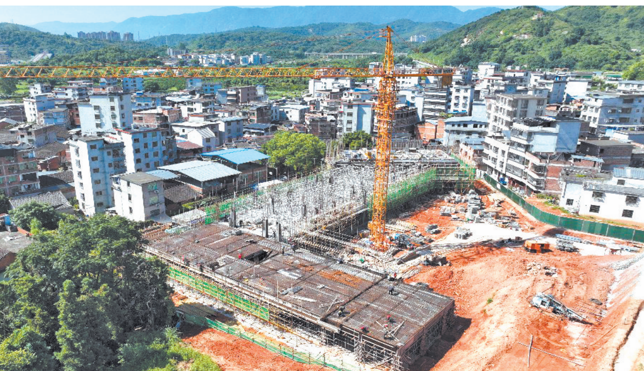
8月9日,航拍下的蕉城区金涵濠坑幼儿园项目建设现场,各项施工环节紧锣密鼓地展开。
