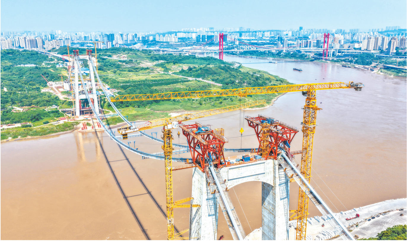
这是7月30日拍摄的重庆黄桶沱长江大桥主缆架设作业现场(无人机照片)。
