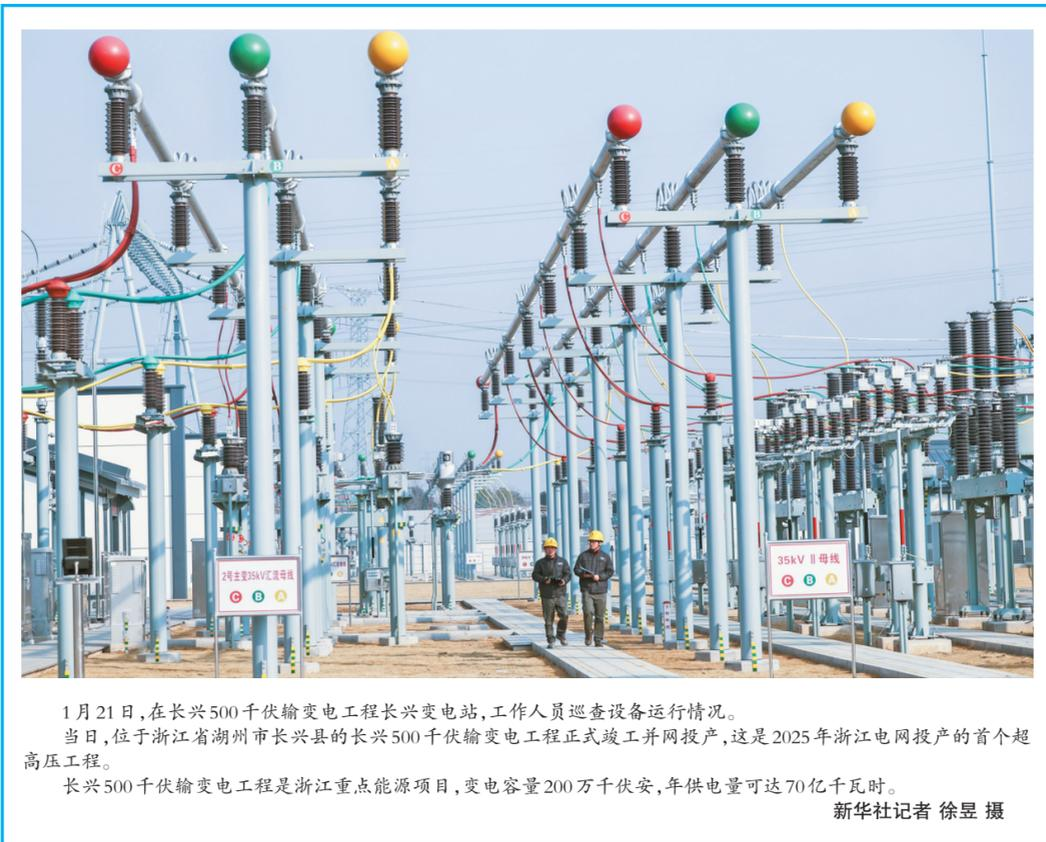
1月21日,在长兴500千伏输电工程长兴变电站,工作人员巡查设备运行情况。当日,位于浙江省湖州市长兴县的长兴500千伏输电工程正式竣工并网投产,这是2025年浙江电网投产的首个超高压工程。长兴500千伏输电工程是浙江重点能源项目,变电容量200万千瓦安,年供电量可达70亿千瓦时。新华社记者 徐昱 摄
