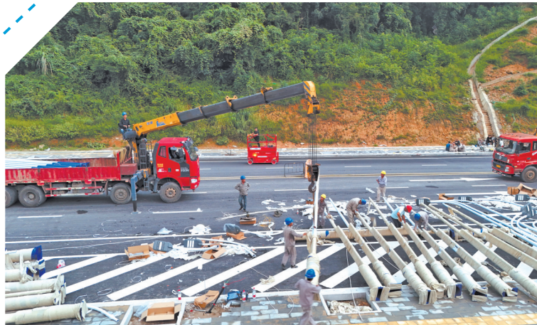
林特路道路工程正在进行路灯安装 孙伏明 摄
