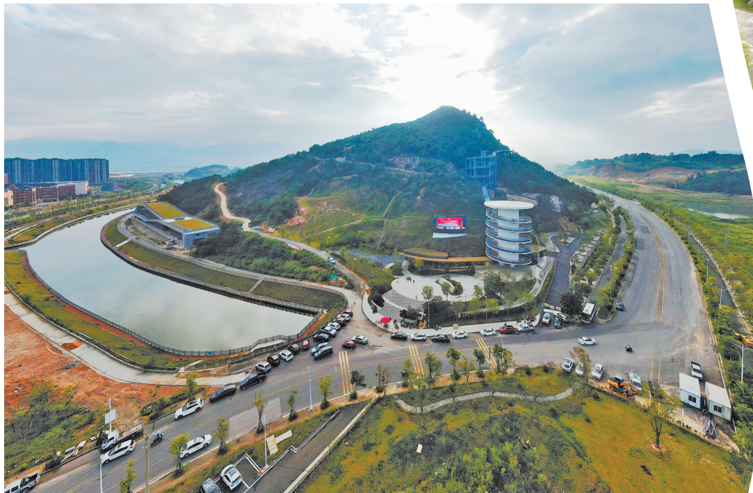
钱岩山城市休闲步道项目已完成主广场和闭环栈道建设,将于10月1日对外开放 朱灵源 摄
