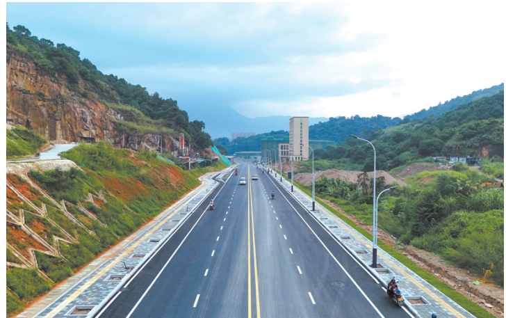
林特路道路工程部分路段已完成路灯安装 孙伏明 摄
