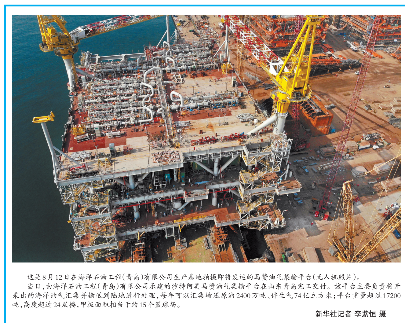
这是8月12日在海洋石油工程(青岛)有限公司生产基地拍摄即将发运的马赞油气集输平台(无人机照片)。
