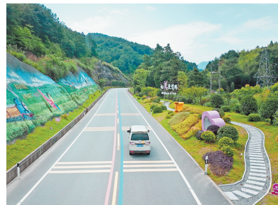
柘荣县东源至鸳鸯头段公路
