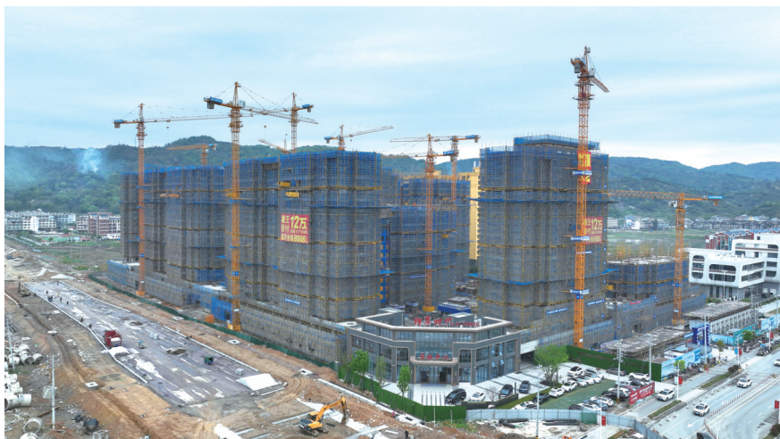
福鼎市锂电公馆项目施工现场
