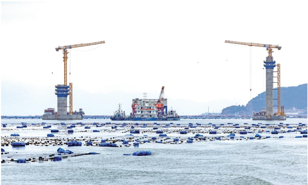
3月26日,宁上高速东吾洋特大桥首个主墩墩身完成浇筑,大桥建设即将进入上部结构施工环节 本报记者 王志涛 摄
