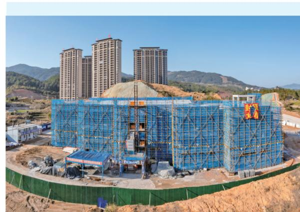
连日来,在屏南县机关幼儿园建设项目现场,工人们正在进行砌体分项工程施工以及部分线管预埋安装。据了解,该项目总投资5019万元,总建筑面积7000平方米,主要建设内容包括一栋教学综合楼及跑道、围墙、绿化等室外配套工程。建成投用后可开办班级15个,提供学位450个,将进一步满足城区学前教育学位适应中心城区中长期发展的需求,推动屏南教育事业更好更快地发展。 本报记者 叶陈芬 摄
