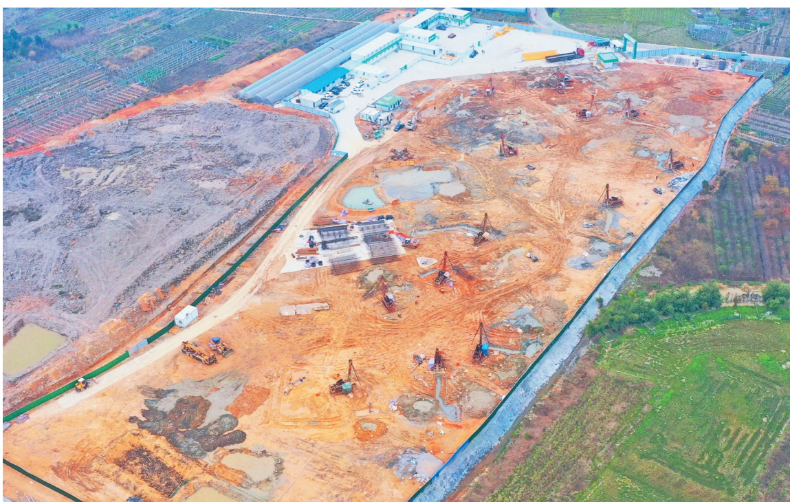
2月29日,在福安一中滨海校区(湾坞中学)项目施工现场,记者看到多台打桩机火力全开,同步展开地下桩基施工作业,现场机声隆隆,一派繁忙景象。
