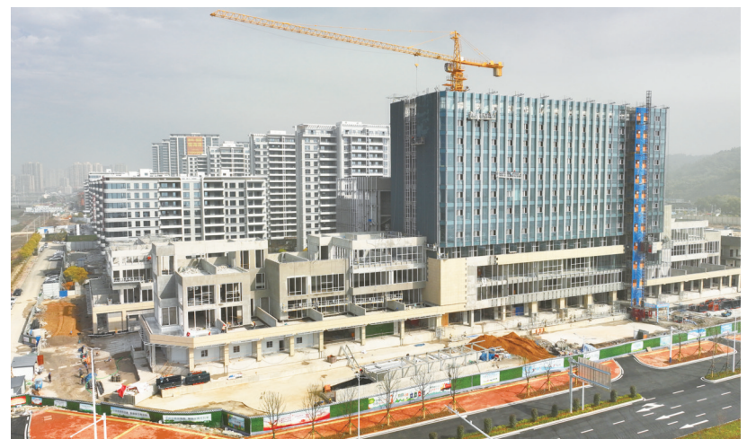
近日,在省级重点文旅项目福鼎羽润环湾大酒店项目施工现场,记者看到客房大楼已经封顶,外立面玻璃幕墙安装过半。该项目总投资4.01亿元,于2023年1月开工建设,占地面积近33亩,建筑面积约6.3万平方米,设计酒店客房200间,餐饮位达2400人。
