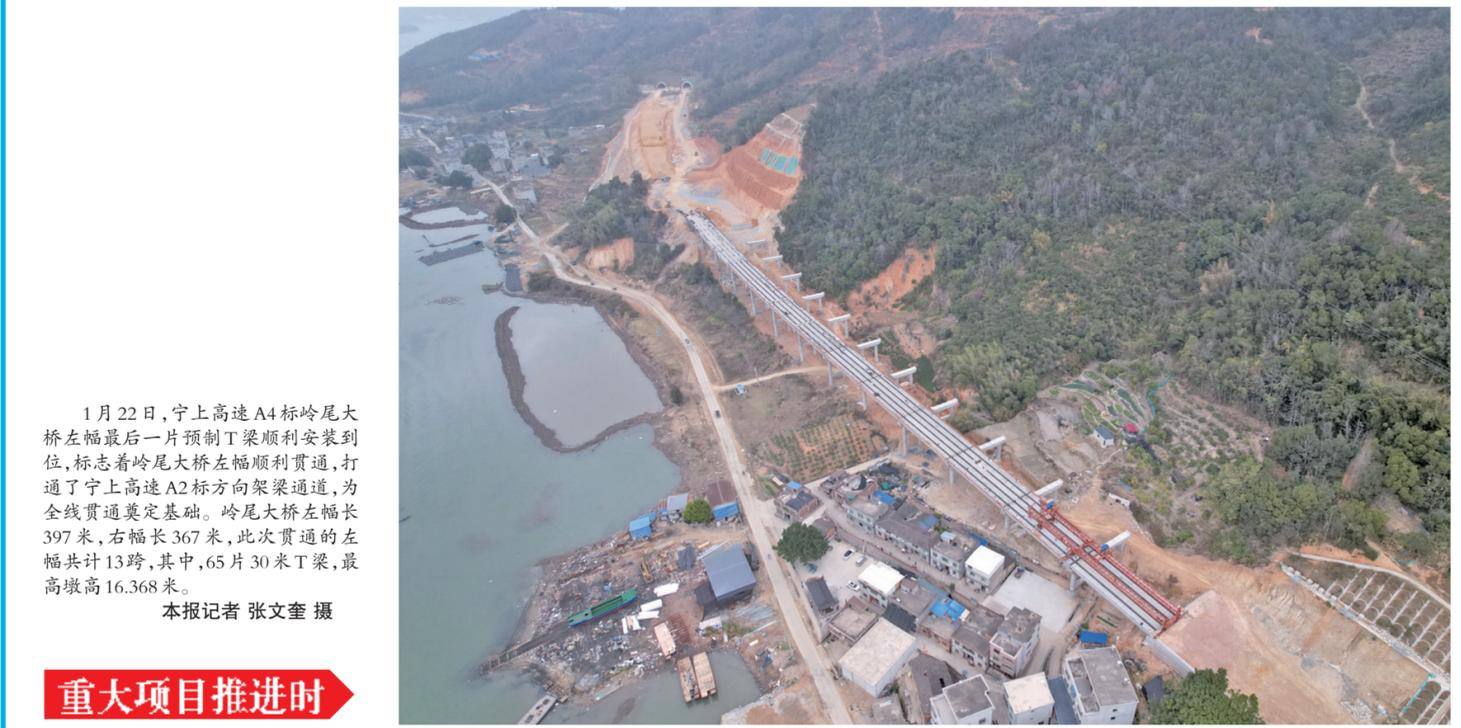
1月22日,宁上高速A4标岭尾大桥左幅最后一片预制T梁顺利安装到位,标志着岭尾大桥左幅顺利贯通,打通了宁上高速A2标方向架梁通道,为全线贯通奠定基础。岭尾大桥左幅长397米,右幅长367米,此次贯通的左幅共13跨,其中,65片30米T梁,最高墩高16.368米。
