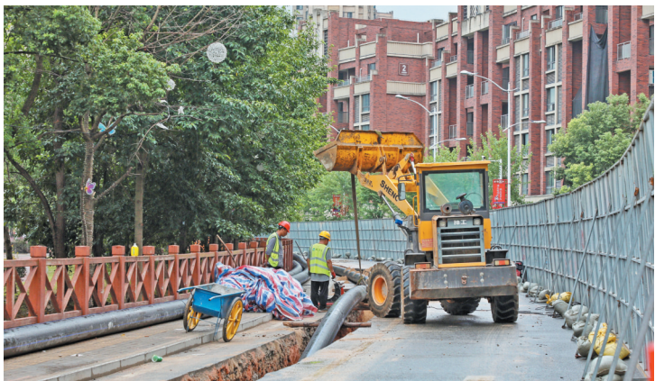
▲污水提质增效工程,推动河道长治久清,还市民清新环境。图为市区金溪路,工人们正在铺设污水管道
