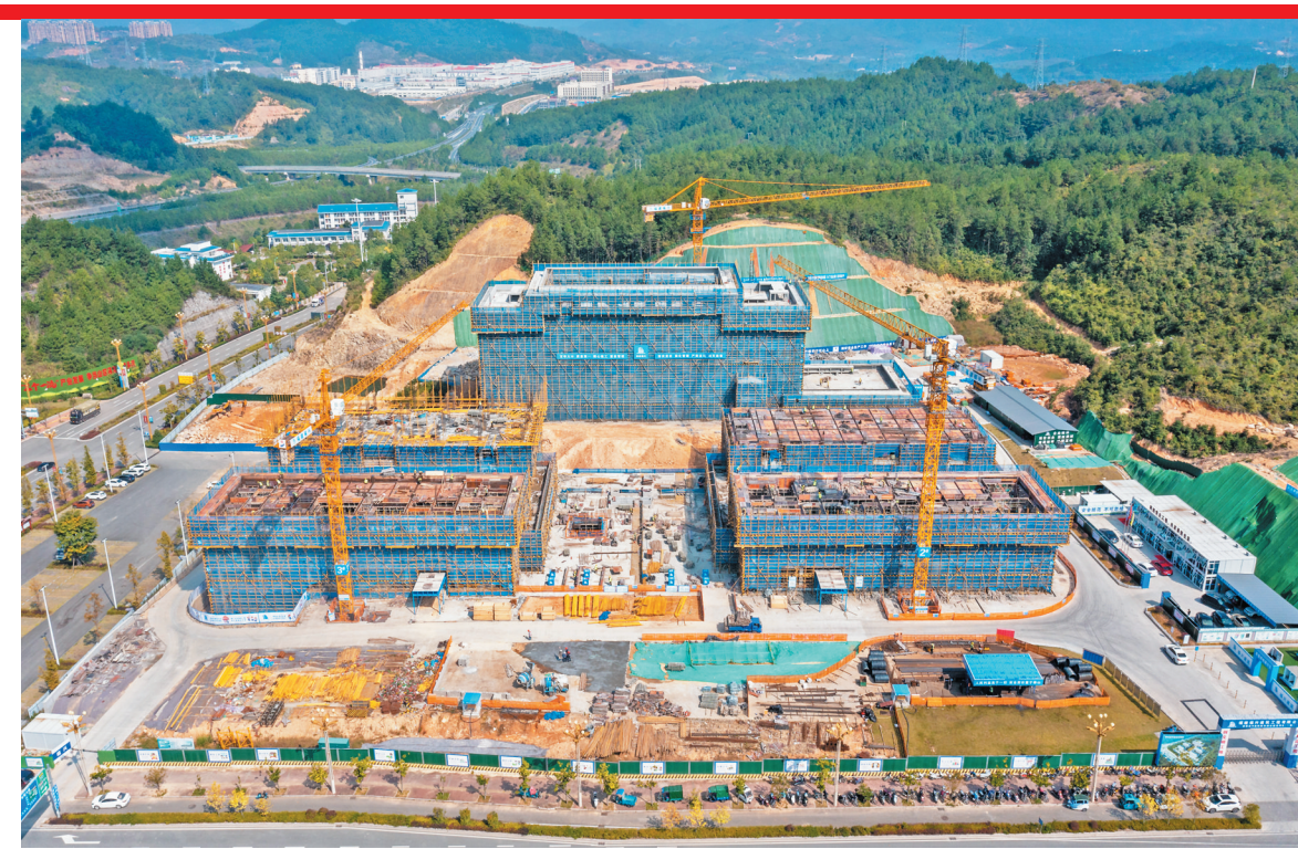
▲屏南中医院整体搬迁建设项目施工现场 王志凌 摄
