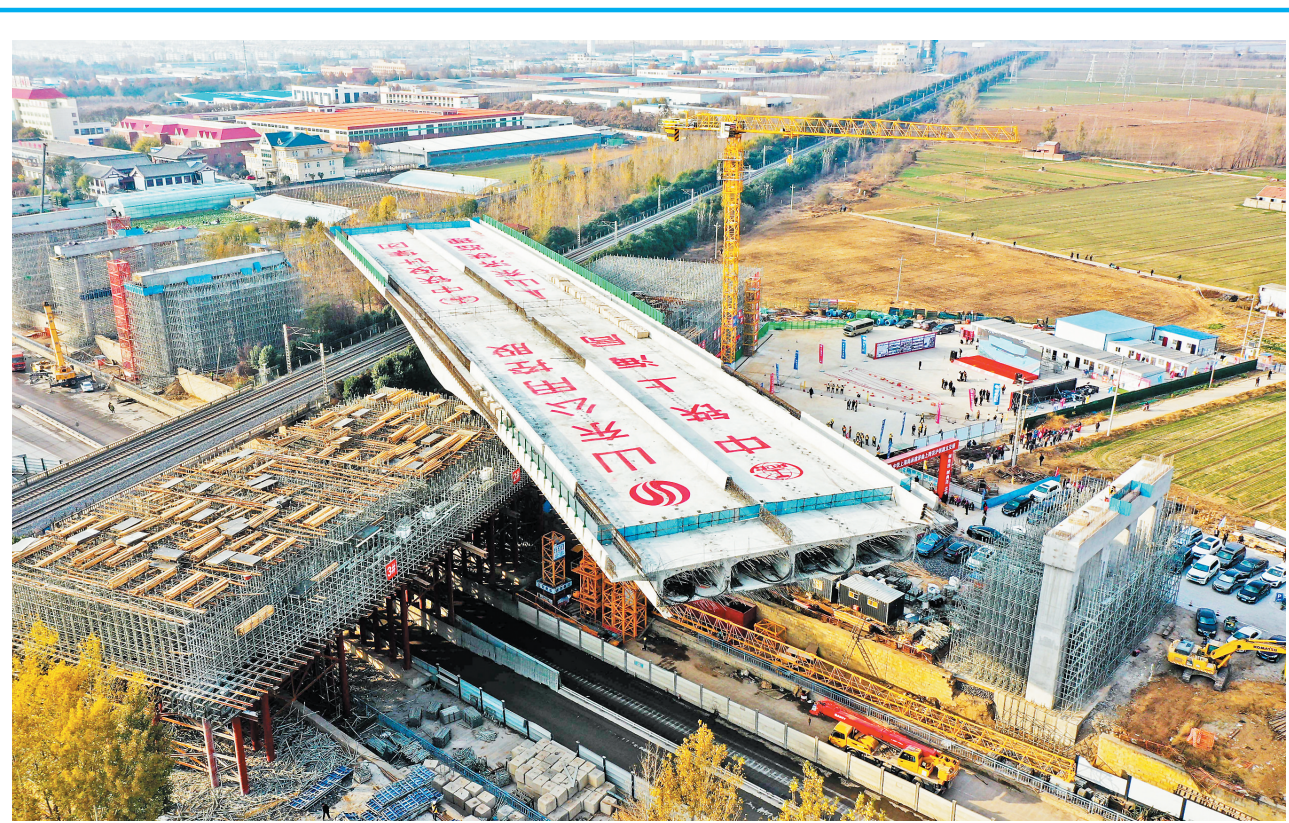
11月28日,由中铁上海局承建的济(宁)曲(阜)快速路上跨京沪铁路立交桥连续梁在转体作业中(无人机照片)。当日,由中铁上海局承建的济(宁)曲(阜)快速路上跨京沪铁路立交桥2×80米T构连续梁成功完成转体作业,为全线通车奠定了坚实基础。 新华社记者 郭绪雷 摄
