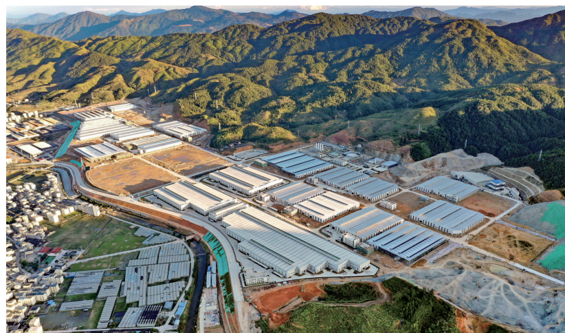
▲周宁不锈钢深加工产业园,带动山城工业强劲崛起 叶晓晖 摄
