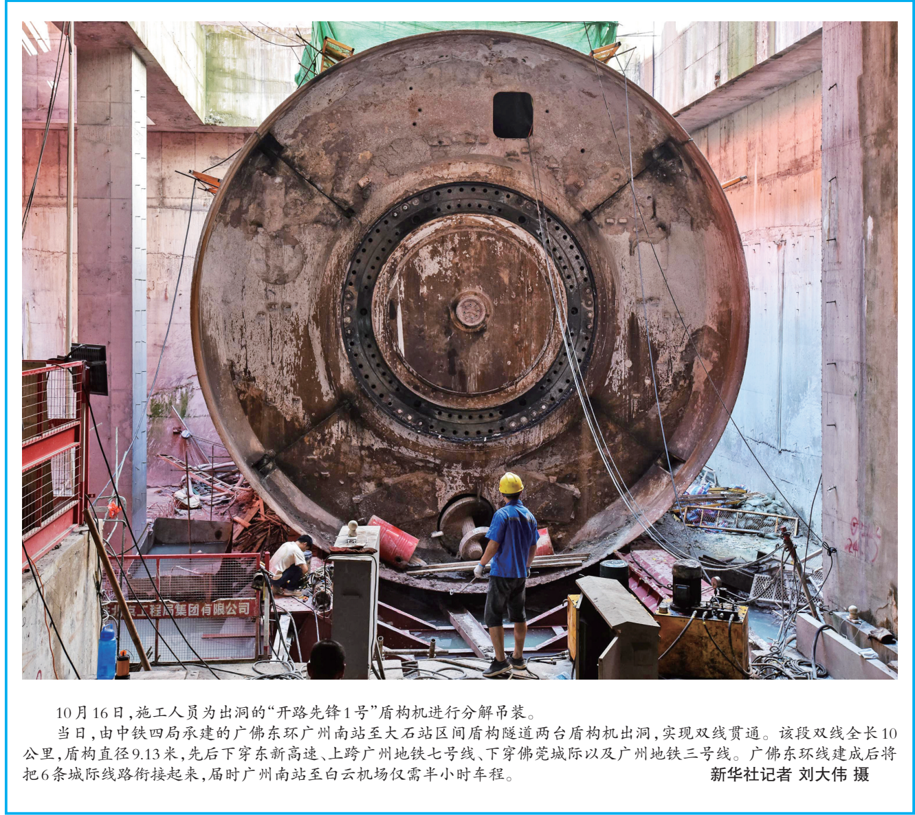
10月16日,施工人员进行出洞的“开路先锋1号”盾构机进行分解吊装。 当日,由中铁四局承建的广佛东环广州南站至大石站区间盾构隧道两台盾构机出洞,实现双线贯通。该段双线全长10公里,盾构直径9.13米,先后下穿东新高速、上跨广州地铁七号线、下穿佛莞城际以及广州地铁三号线。广佛东环线建成后,将把6条城际线路衔接起来,届时广州南站至白云机场仅需半小时车程。 新华社记者 刘大伟 摄
