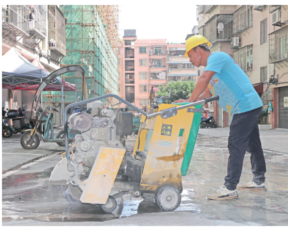
工人正在道路改造作业
