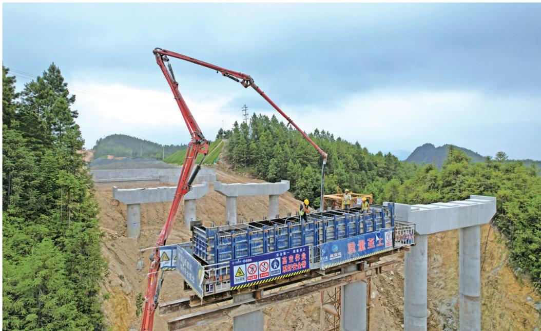
9月14日,宁古高速甲竹大桥最后一根盖梁顺利浇筑,成为宁古高速古田段首个完成下部结构施工的桥梁,为后续70片预制T梁架设奠定基础。甲竹大桥位于古田县大甲镇境内,桥长217米,桥面宽度26米,按双向四车道设计。随着盖梁浇筑完成,工程将进入上部结构架梁施工,为后续鸳鸯谷互通桥梁、谈书院大桥T梁的架设打开运梁通道,也为本标段桥梁施工顺利完成提供保障。
