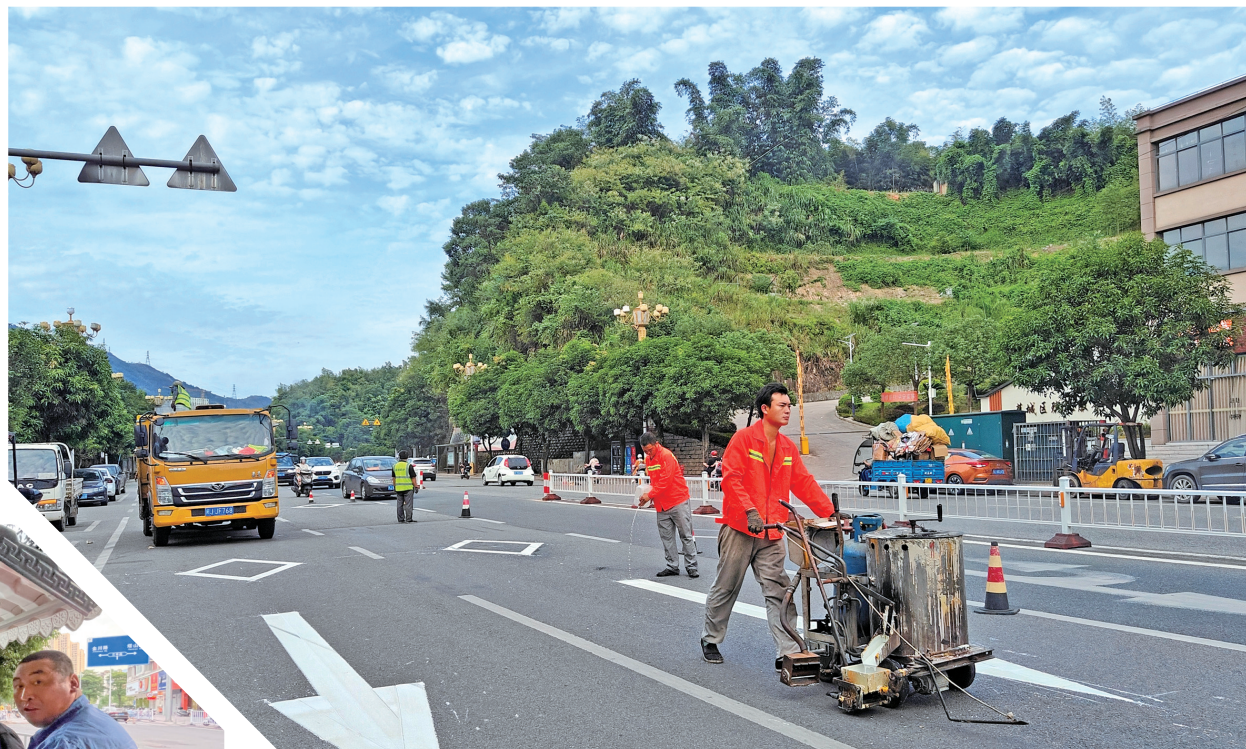
▲9月12日,在宁德市区单石碑路,施工人员正在按计划施划新的标志标线。连日来,交警直属一大队安排设施维护队,在侨兴路、富春路、八一五路、单石碑路等路段,对模糊、缺失的道路标线进行修复,让标线更加清晰、明朗,方便每个交通参与者按道路交通标线指示各行其道、安全文明驾驶。 本报记者 郑霄 摄
