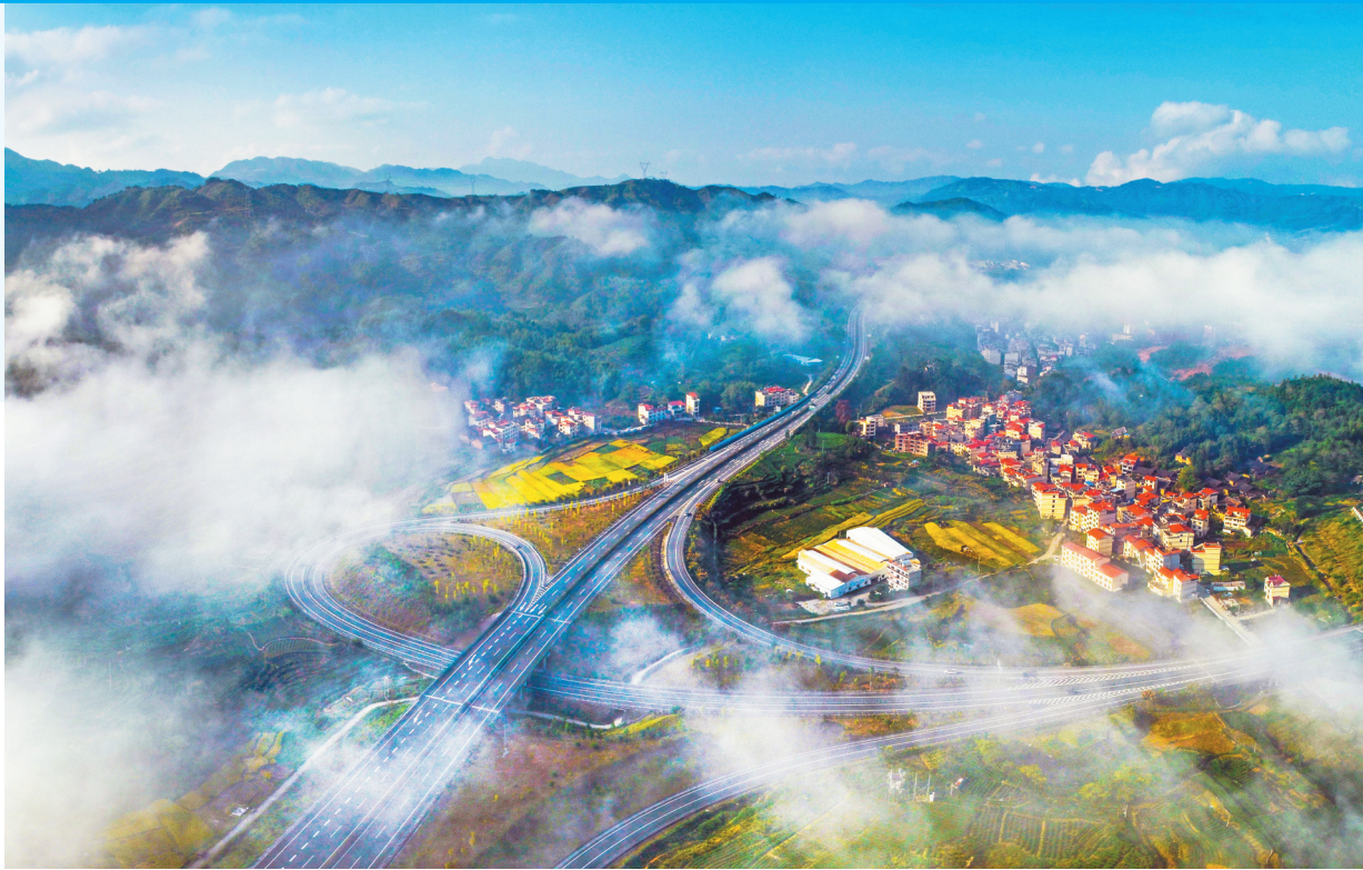
福寿高速南阳互通口 卓仕尉 摄
