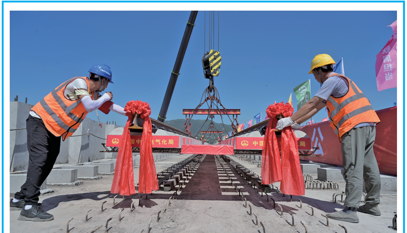
6月1日,中国中铁电气化局施工人员在福州滨海快线首占西高架铺设轨排。当日,福州滨海快线开始铺轨施工建设。滨海快线是连接福州主城区与长乐滨海新城以及福州长乐国际机场的轨道交通线,全长约62.4公里,设计时速为140公里。新华社记者 林善传 摄
