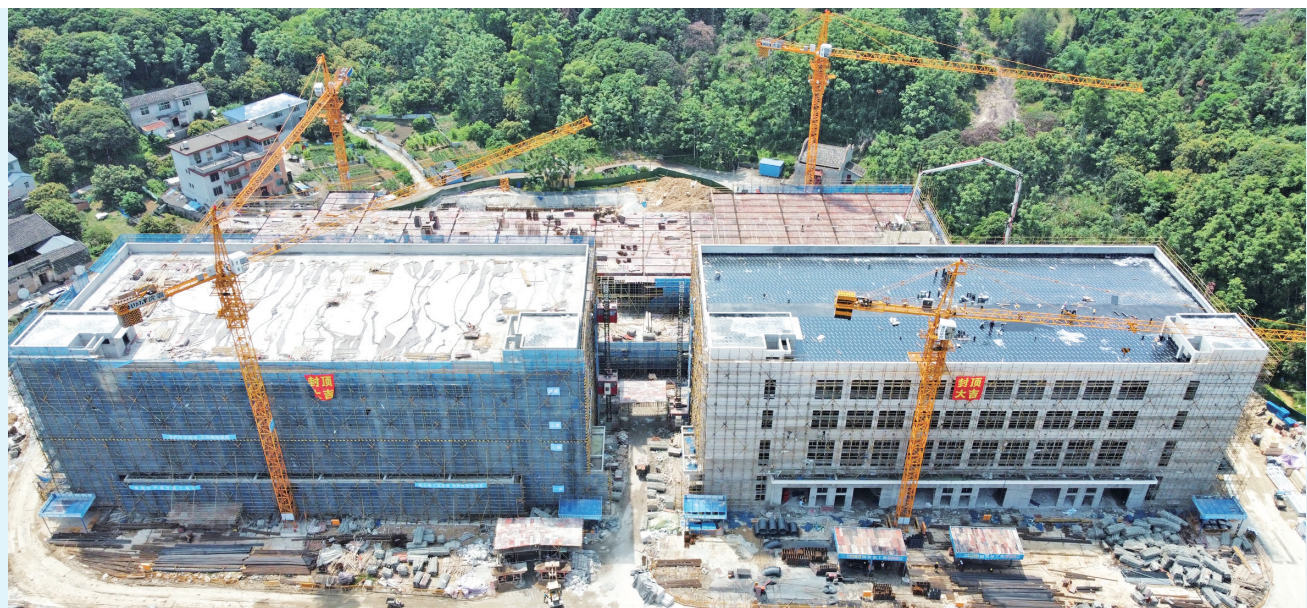
5月29日,在宁德飞鸾物流产业园项目现场,1#、2#仓库已完成砌体工程,正在进行装饰装修及安装工程。
