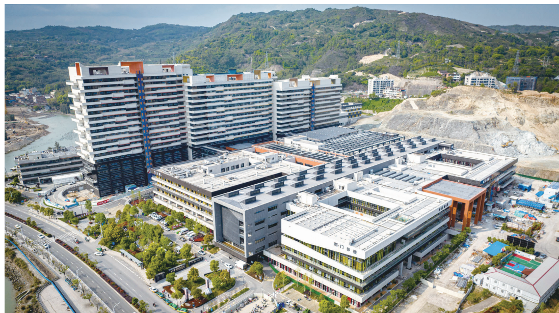
5月16日,福鼎市医院百胜新院区二期工程加紧内部装修施工,预计明年初投入使用。据了解,该项目是省市重点项目,主要建设1栋门诊综合楼、2栋病房综合楼,共设置床位800张。项目建成后将进一步完善福鼎市医疗卫生资源配置,提升医疗卫生服务供给能力。刘超超摄
