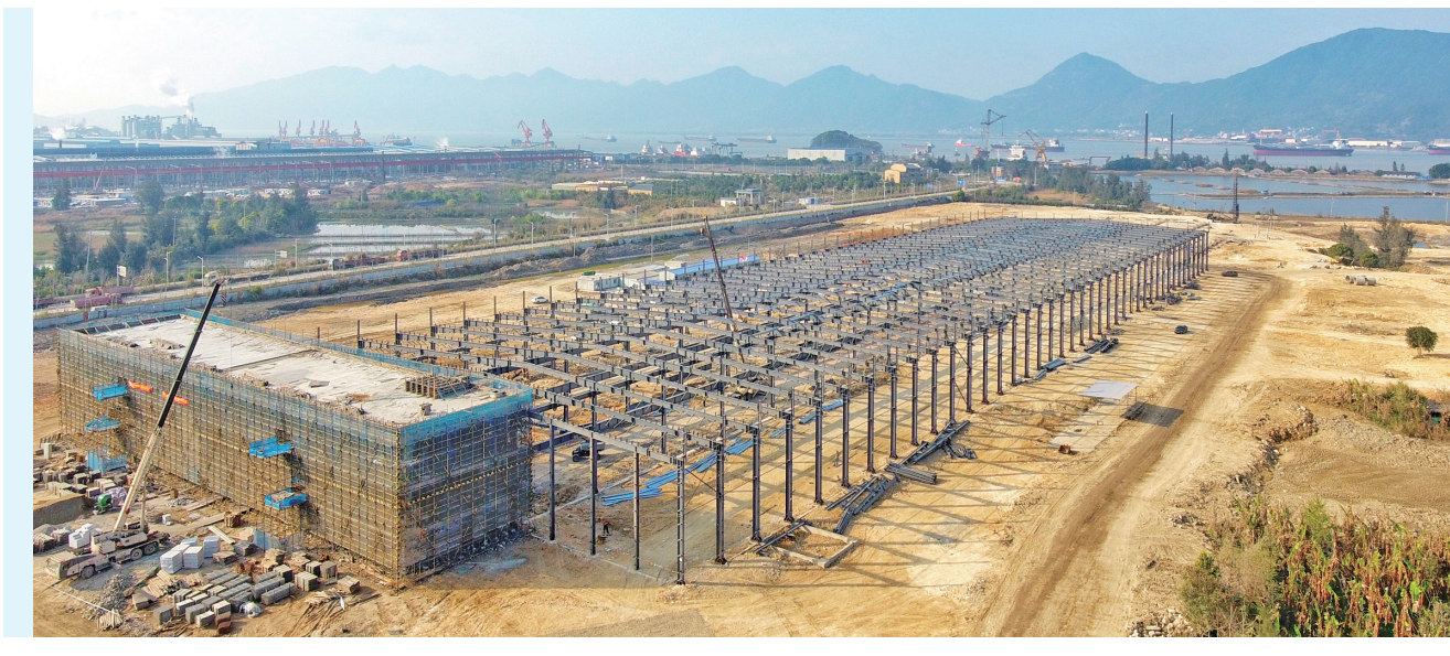
近日,在福安湾坞青拓矿卡项目施工现场,办公楼已经封顶,总装车间钢结构厂房完成70%。预计钢结构在6月中旬完成。据了解,该项目将建成具备2万辆新能源卡车整车及车身、车架、电池PACK生产能力的全新生产基地,致力于打造高品质、高环保、极具竞争优势的不锈钢新材料、新能源产品及循环经济园区。矿卡项目及总成零部件项目达产后可实现年工业产值150亿元以上。 本报记者 张文奎 摄
