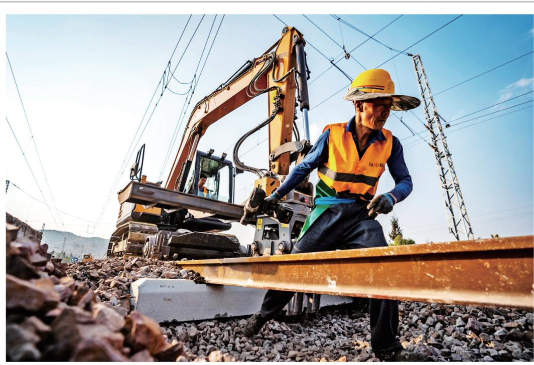
作业人员操作换枕设备对铁路进行换枕作业(3月8日摄)。3月8日下午,在南(宁)昆(明)铁路石林南站,数十台大型机械沿铁路线依次排开,南昆铁路开通运营以来机械化程度最高、规模最大的一次大修施工全面展开。此次南昆铁路大修施工将持续至6月,铁路部门在保障线路正常运营的同时,组织施工人员利用85个“天窗期”完成轨枕大修131公里、换枕100公里、桥梁隧道病害整治25处,大修完成后将极大提升南昆铁路线路设备质量和运输效率。南昆铁路全长近900公里,途经滇黔桂三省区,于1997年正式开通运营。 新华社记者 江文耀 摄
