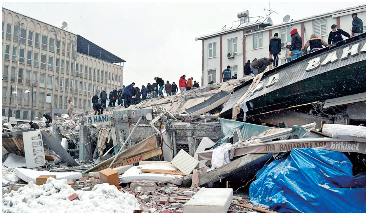
二月六日,人们聚集在土耳其马拉蒂亚一处倒塌的建筑附近。(新华社发 穆斯塔法·卡亚摄)
