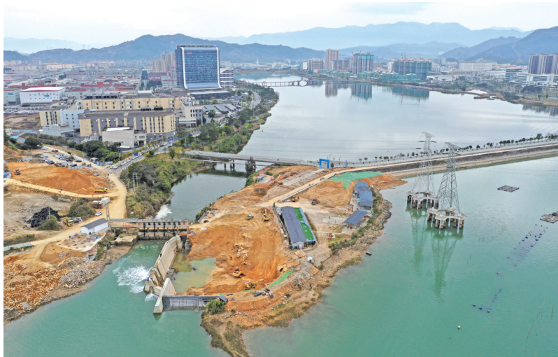
2月1日，在西陂塘(赤溪湖)防洪防潮提升改造工程建设现场，挖掘机正对土方进行挖掘作业。该项目将于今年4月底完成左岸两孔水闸建设并投入使用。据了解，该项目是2023年省重点项目，位于宁德市北部新区西陂塘，总投资2.1亿元，是我市主城区防洪防潮排涝规划的重要组成部分。为进一步加快项目建设，施工单位放弃春节假期，统筹抓好人员和物资安排，确保项目建设有序推进。
